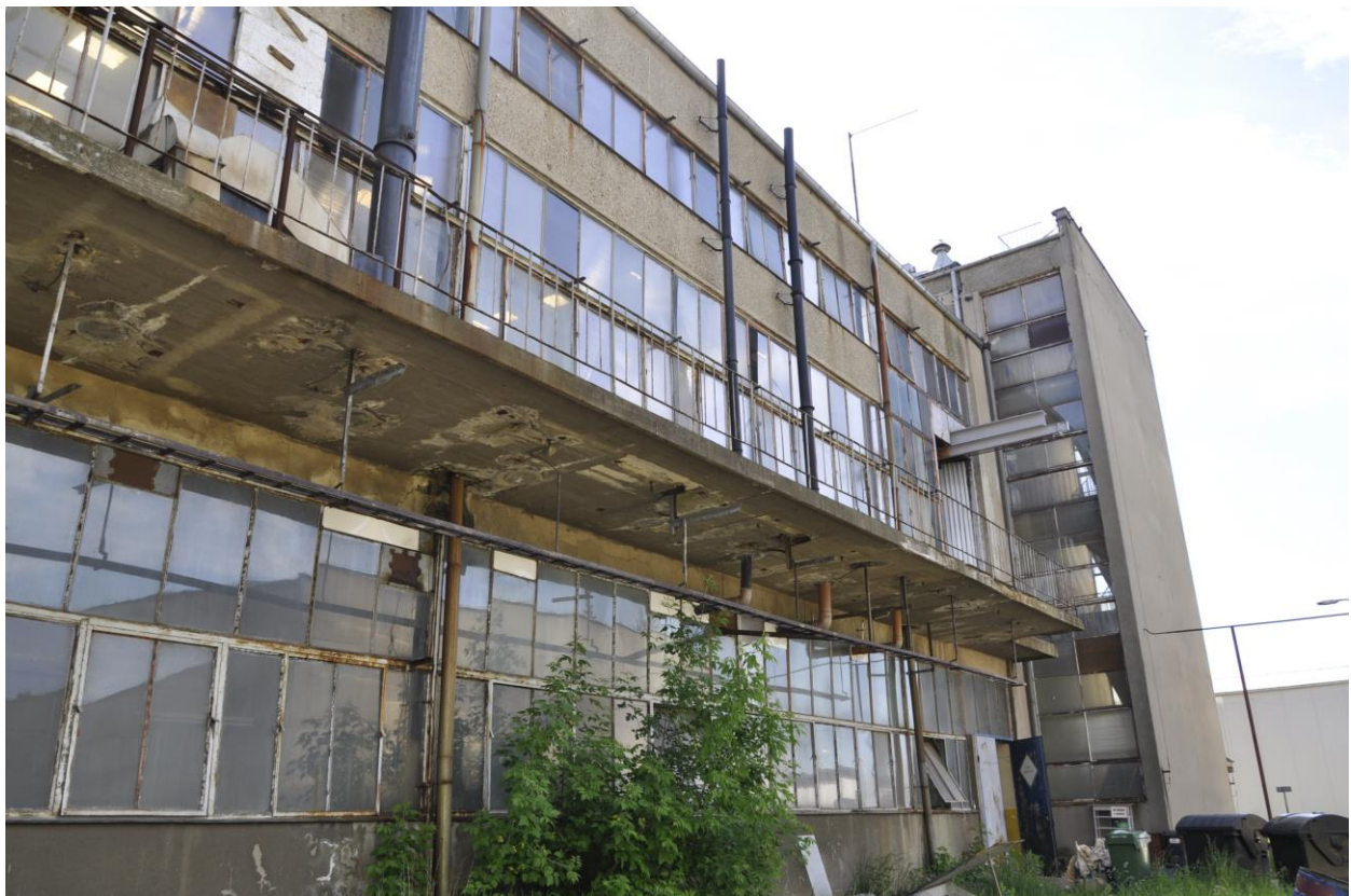
Obudowa hali podlegająca wymianie.
