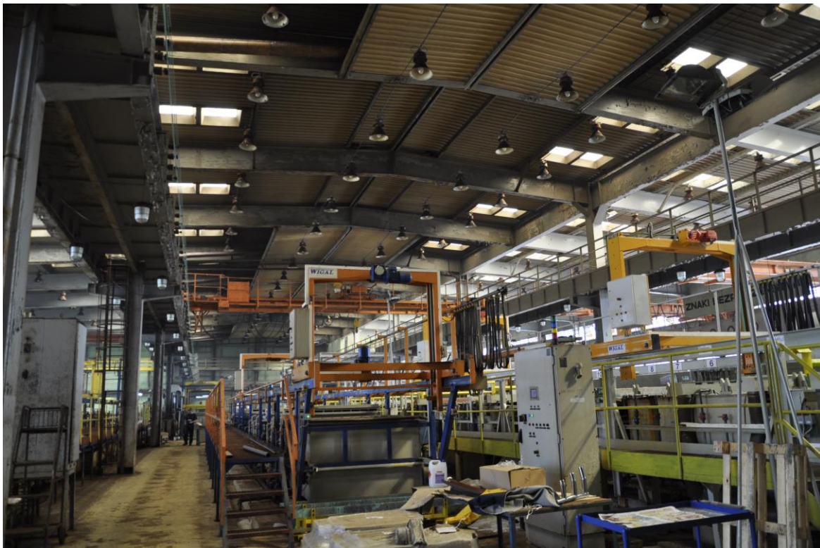
Widok wnętrza hali.
