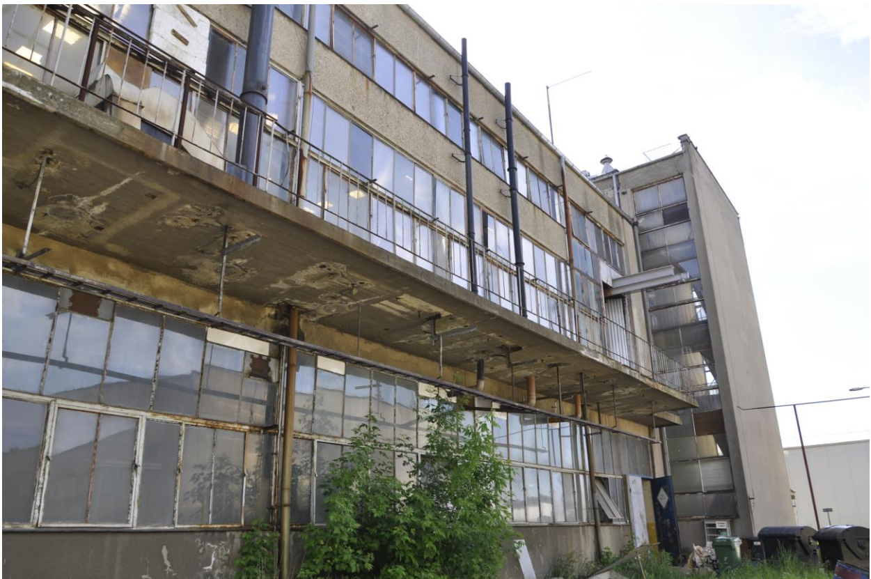
Obudowa hali podlegająca wymianie.
